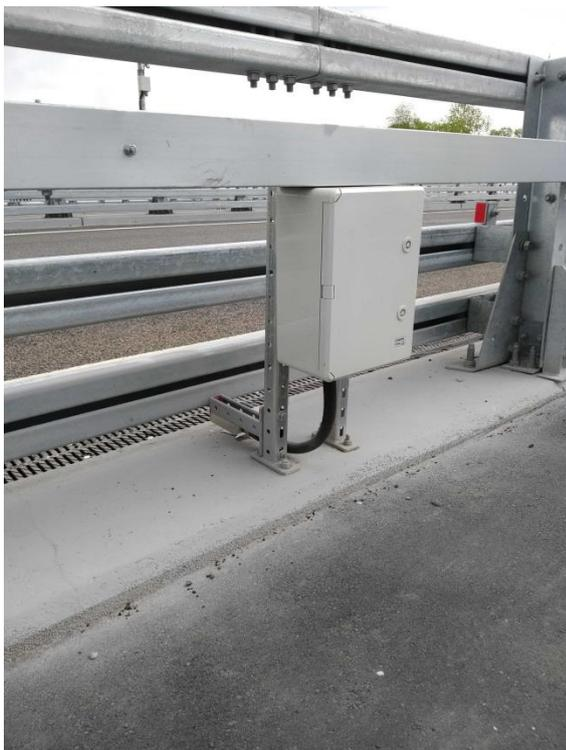
Блок управления форсункой БУФ-12 предназначен для работы в составе комплекса автоматических систем противогололедной обработки АСПО. БУФ-12 осуществляет открытие клапана по команде от центрального блока управления, диагностику его открывания и закрывания после окончания разбрызгивания жидкого противогололедного реагента.
